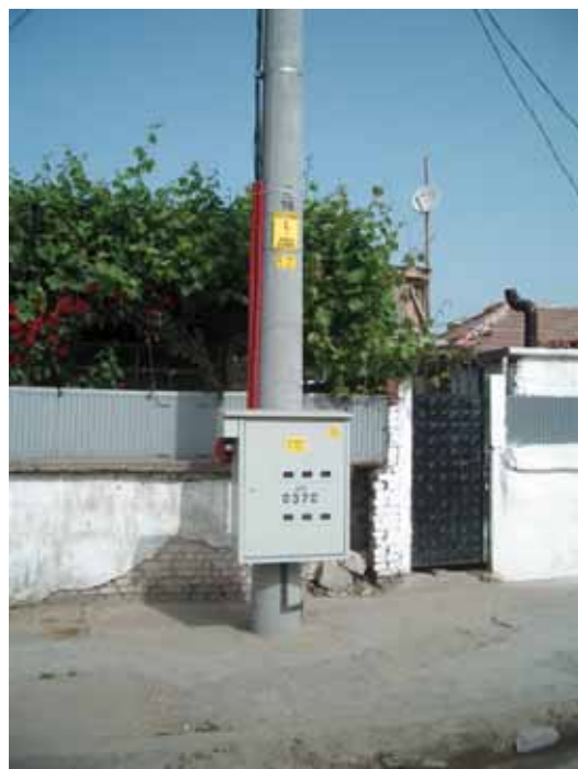
Табло монтирано в рамките на проекта на EVN България, осигуряващо нормален визуален Достъп на клиента до показанията.
