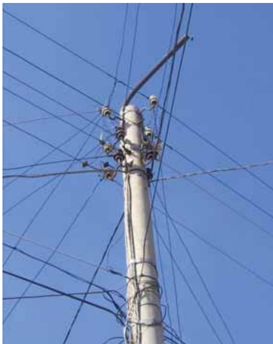
Пример за самоволно присъединяване към разпределителната мрежа НН, преди проекта на EVN България в Столипиново
