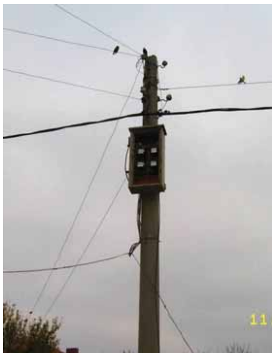
Разбито електромерно табло в квартал Столипиново, преди реализира- не на проекта на EVN България за модернизиране на мрежата
